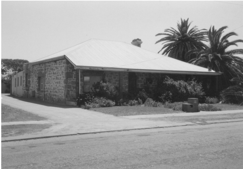
Photo Description: 14/10/1996 Suba & Grundy Random stone walls.
