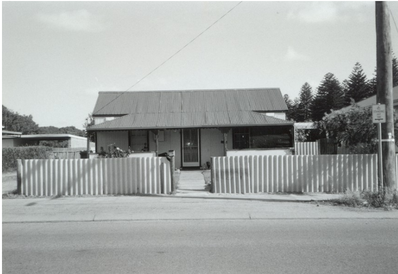
Photo Description: 15/10/1996 Suba & Grundy The north elevation.
