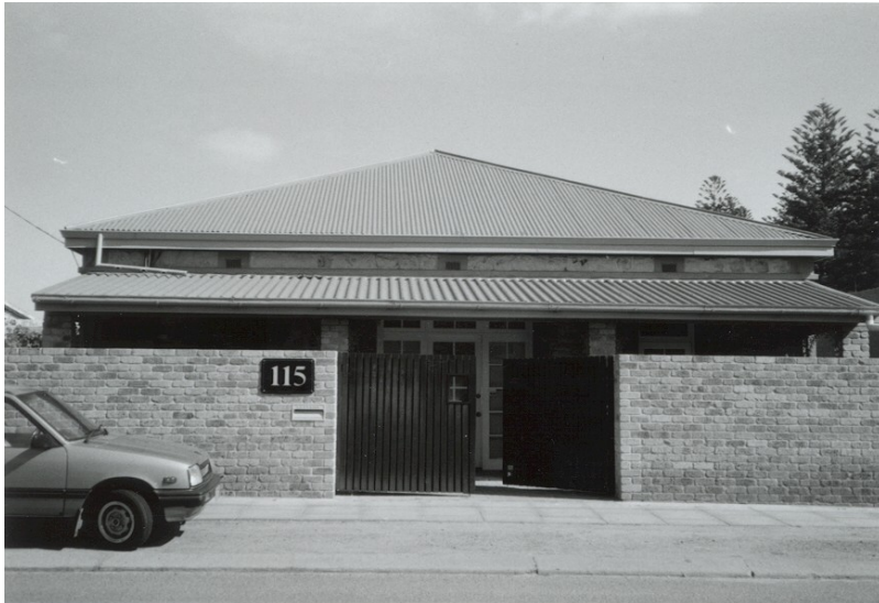
Photo Description: 15/10/1996 Suba & Grundy Brick verandah pillars.
